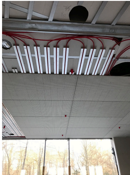
Køle- og varmesystemet er integreret i loftet.
